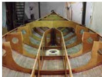
外板の作業はどこまで進んでいるかわからないが、ボートを反転して正立にしたところ。この状態で、ある程度の艤装を取り付けるのかもしれないが、デッキを貼ればボートの形になる
