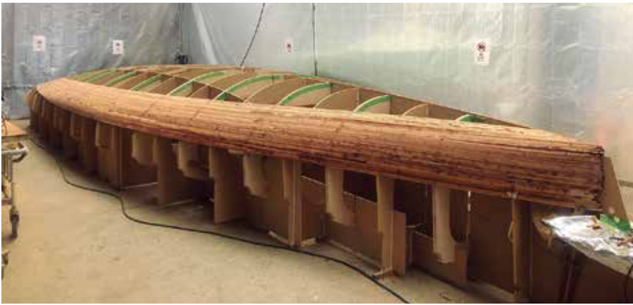
フレーム類を倒立に組み、右舷側のストリップをまず取り付けている。ここまで来るには膨大な作業があったはずだ。ビルダールの梅川尚敬氏は、基本的に一人だけで建造作業にあたった
